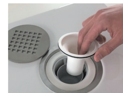
Retirer le siphon anti-odeur
