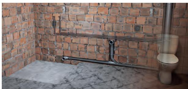
Lors de la rénovation d'une salle de bains/douche, il n'est souvent pas possible d'installer des douches de plain-pied avec évacuation par gravité. La pente nécessaire pour l'évacuation fait défaut, car le raccordement à la conduite de chute se trouve trop haut dans le mur.
