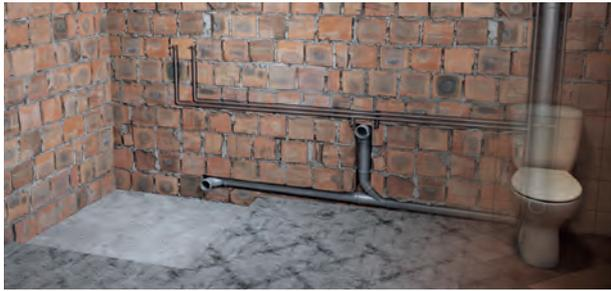
Bei Bad-/Duschsanierungen ist es oft nicht möglich, bodengleiche Duschen mit Schwerkraftentwässerung zu installieren. Das nötige Gefälle für den Ablauf fehlt, da der Anschluss an die Falleitung zu hoch in der Wand liegt.
